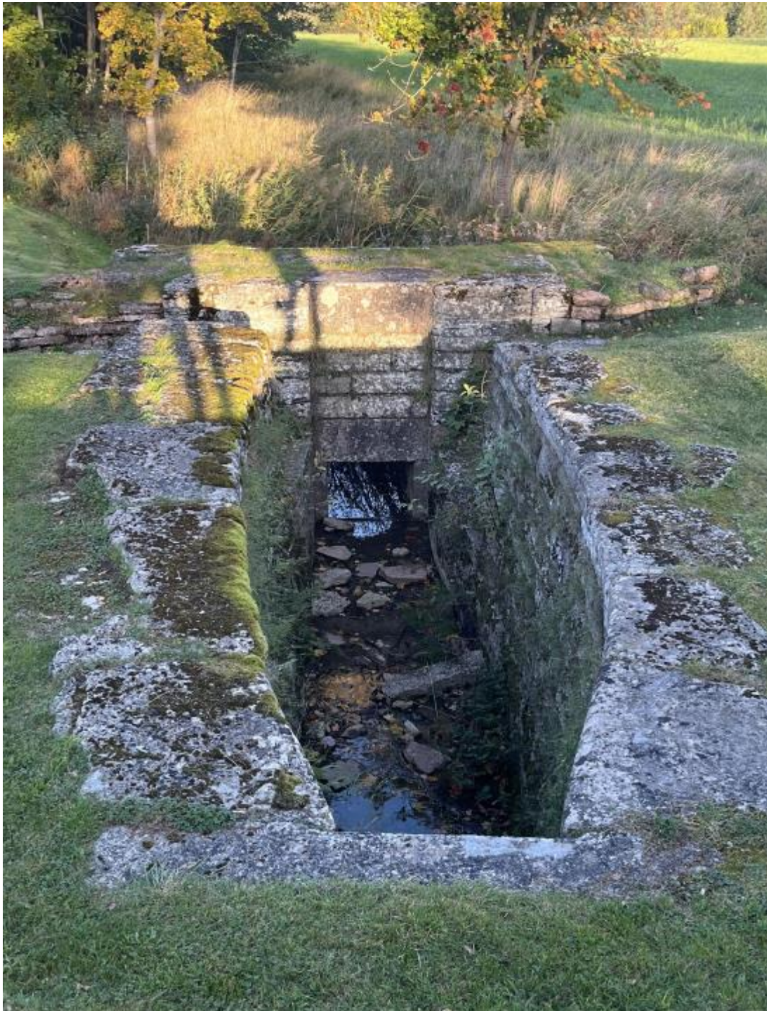
Avledningen på andra sida kanalvallen, där vattnet leds ut i olika diken.
